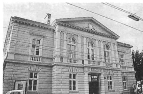
Das Maurer Rathaus 1999 renoviert!
