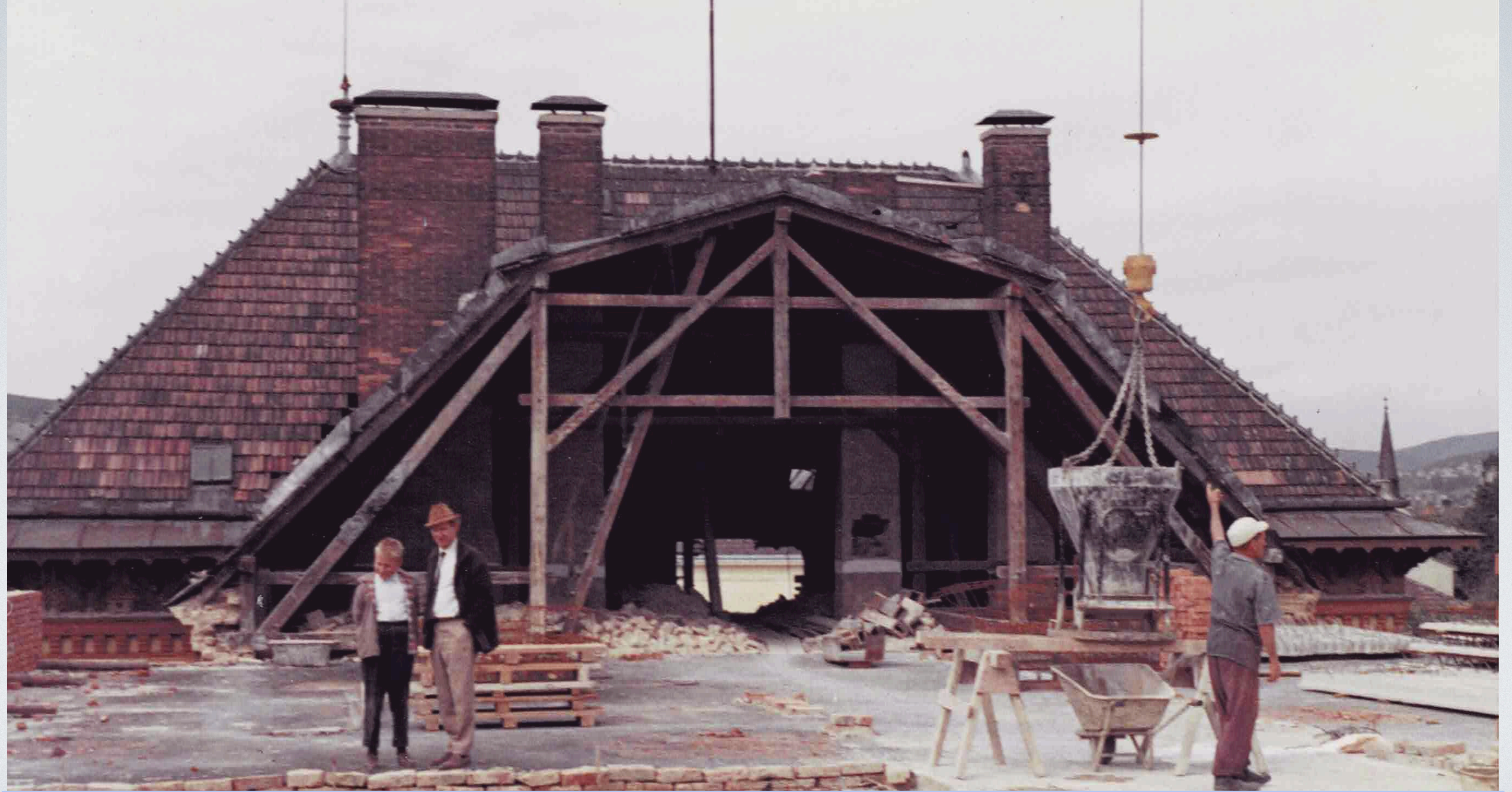
Schulumbau 1964-1966 Blick nach Westen
