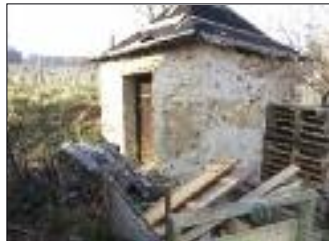
Hiatahütten als historische Quellen. Fotos: Ing. Horst Zecha.
