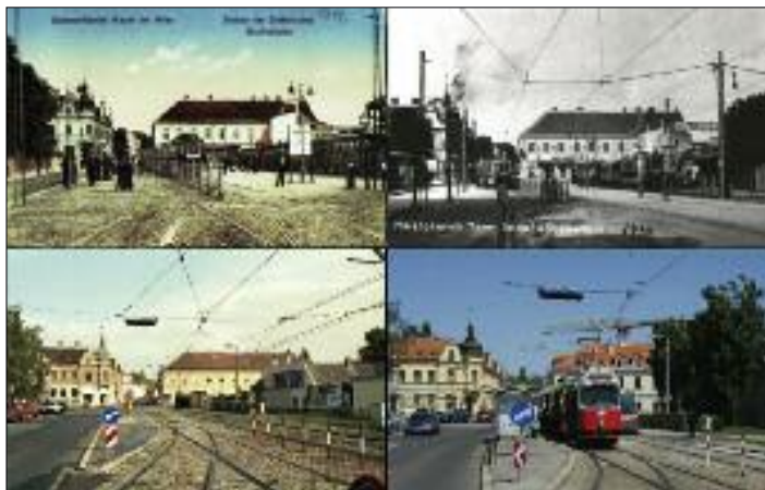
Station Maurer Lange Gasse im Wandel der Zeit ...
